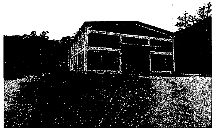
Figura 16 – Fachada do prédio da marcenaria.
