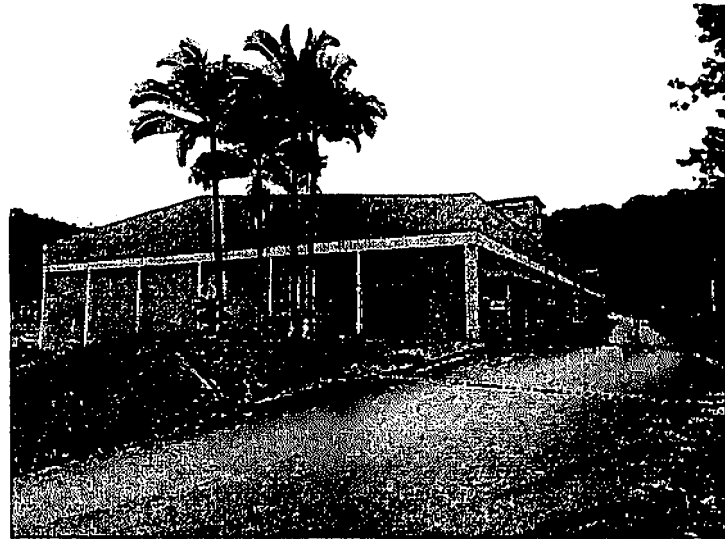
Figura 26 – Edificação da tecelagem IV.
