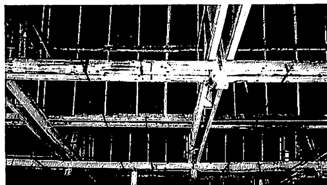
Figura 217 – Interna: Cobertura em Madeira Fonte: Do Autor, 2015
