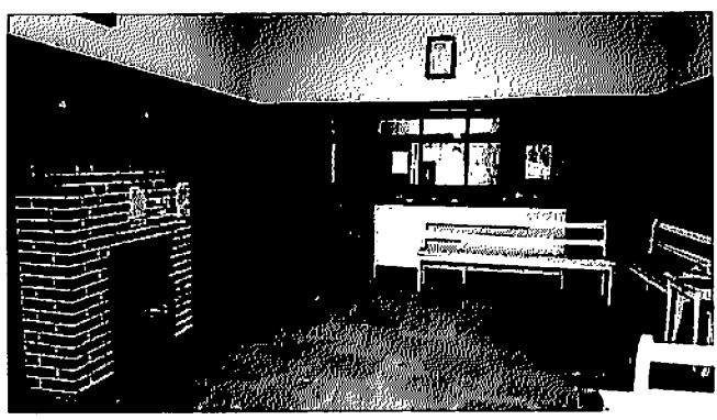
Figura 56 – Interno: Pavimento Inferior Fonte: Do Autor, 2015.
