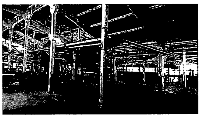
Figura 38 – Interna: Estrutura em Concreto Pré-Moldado Fonte: Do Autor, 2015.
