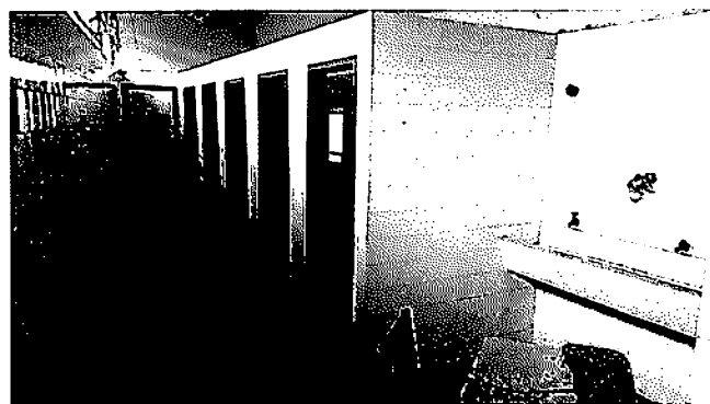
Figura 191 – Interna: Banheiro Feminino Fonte: Do Autor, 2015
