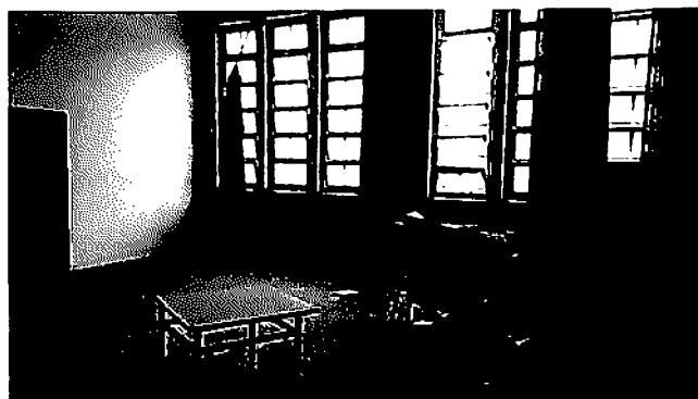
Figura 155 – Interna: Pavimento Superior Fonte: Do Autor, 2015.
