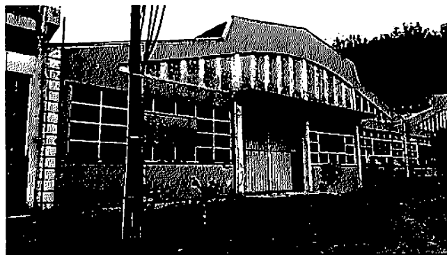
Figura 35 – Fachada Fonte: Do Autor, 2015.
