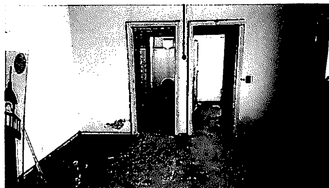
Figura 157 – Interna: Banheiros Fonte: Do Autor, 2015.
