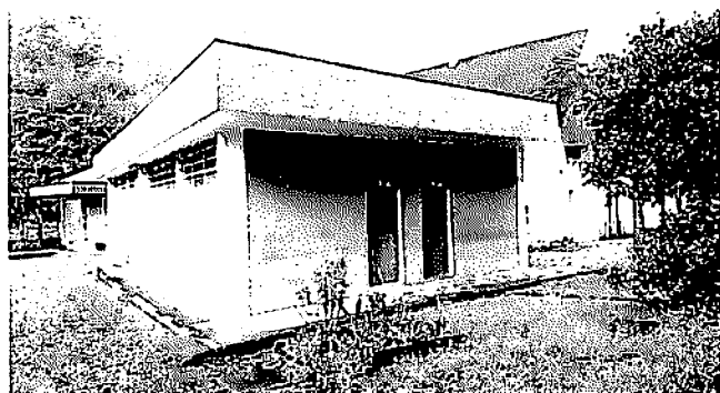
Figura 189 – Fachada Fonte: Do Autor, 2015.
