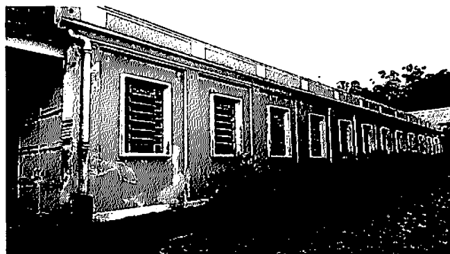
Figura 183 – Fachada Fonte: Do Autor, 2015.
