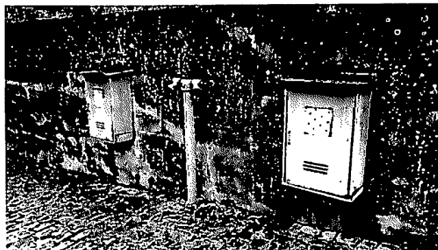
Figura 165 – Externo: Sistema Preventivo contra Incêndios Fonte: Do Autor, 2015.
