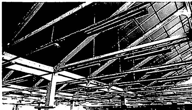
Figura 188 – Interna: Cobertura Fonte: Do Autor, 2015.
