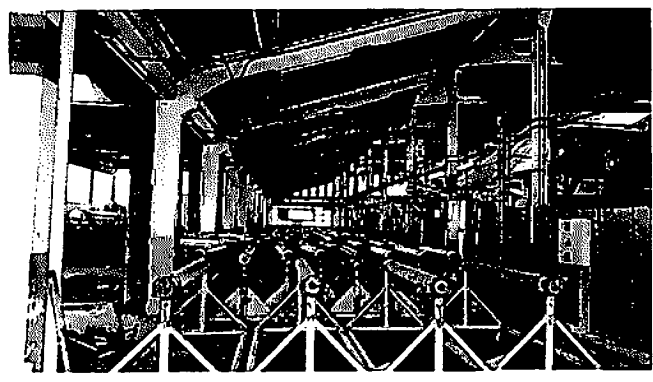
Figura 40 – Interna: Estrutura em Concreto Pré-Moldado Fonte: Do Autor, 2015.
