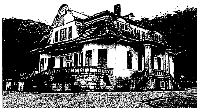
Figura 54 – Fachada Fonte: Do Autor, 2015.
