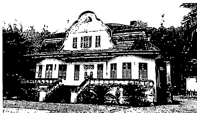
Figura 55 – Fachada Fonte: Do Autor, 2015.
