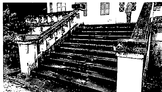
Figura 66 – Externo: Escadas Fonte: Do Autor, 2015.
