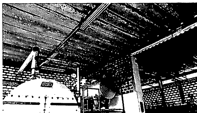
Figura 195 – Interna: Cobertura Fonte: Do Autor, 2015
