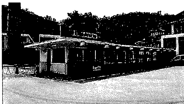
Figura 142 – Fachada Fonte: Do Autor, 2015.
