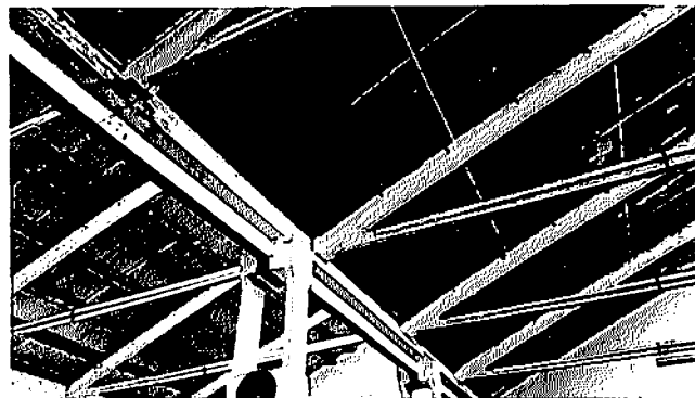
Figura 93 – Estrutura: Cobertura Fonte: Do Autor, 2015.
