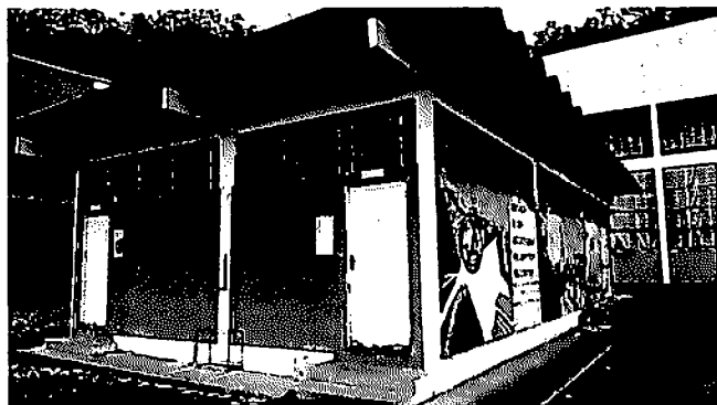
Figura 74 – Fachada Fonte: Do Autor, 2015.
