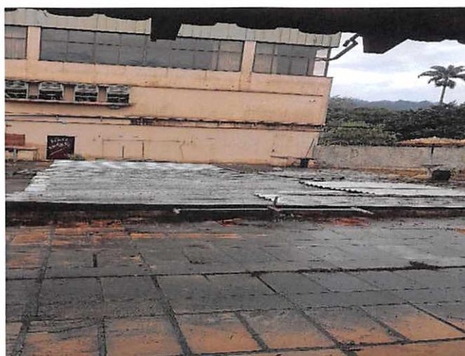
Em dezembro de 2016, foi feita a primeira drenagem na água da piscina e posteriormente tampada com placas de zinco. Algumas placas foram retiradas sendo necessário a reposição desse material duas vezes.
