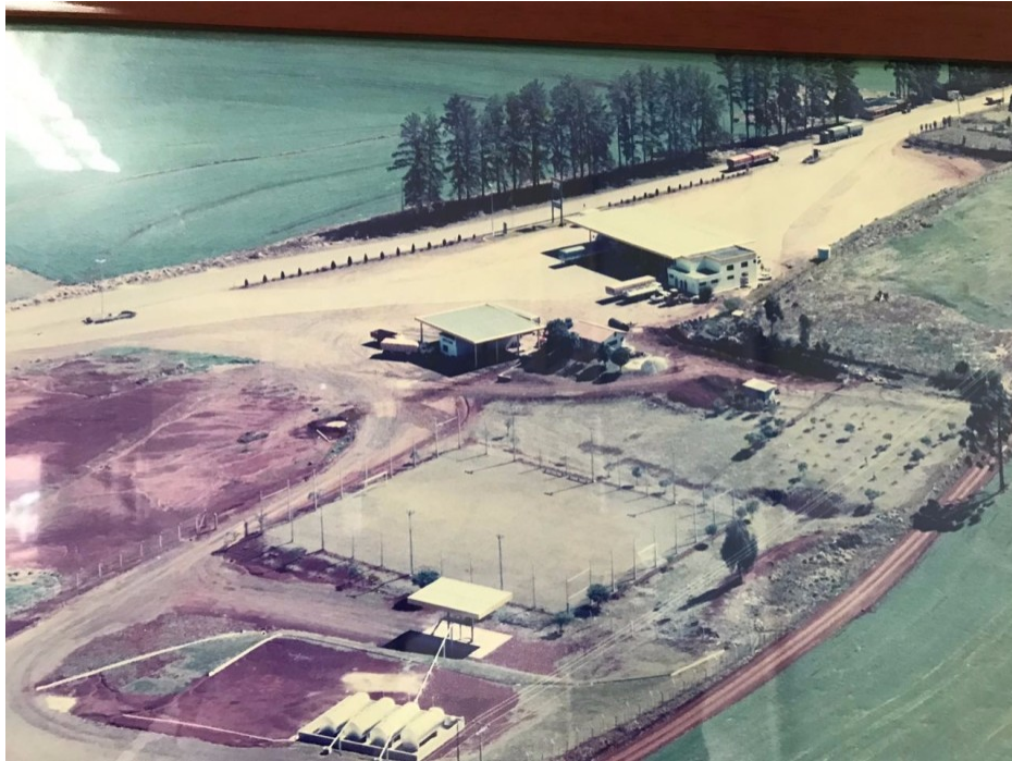
Figura 1 – Vista Aérea – TRR Gilioli e Posto São João - Área 8.664 m 2 Matrícula 4970 – Ofício de Registro de Imóveis de Abelardo Luz/SC
