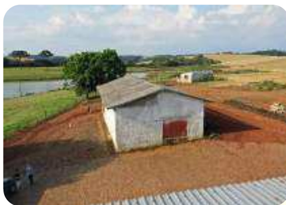
Foto 8: Barracão em Alvenaria, matrícula de n. 9.897 do CRIAL. Fonte: Acervo Particular da Empresa Avaliadora.
