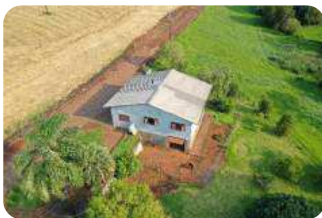
Foto 5: Casa em alvenaria, matrícula de n. 9.897 do CRIAL. Fonte: Acervo Particular da Empresa Avaliadora.
