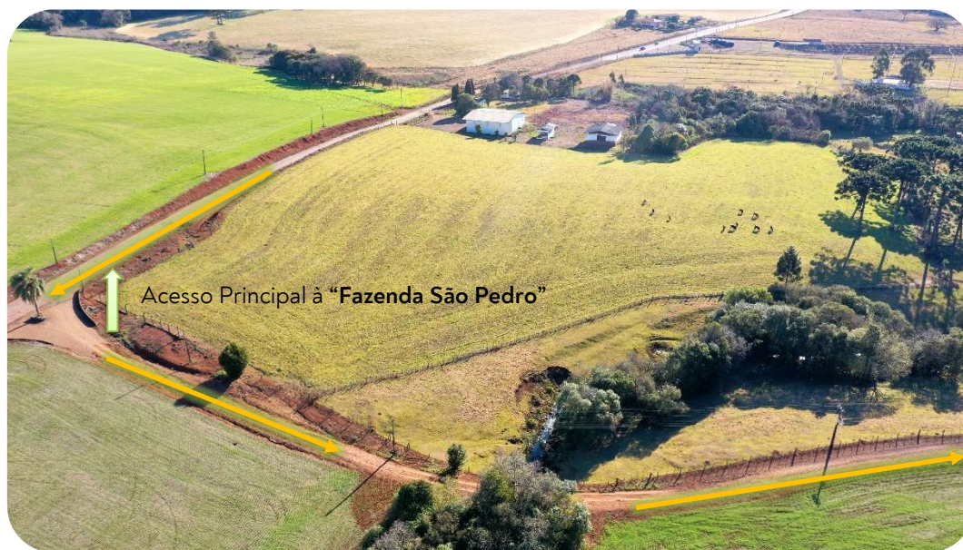
Foto 1: Aérea, indicação da entrada na propriedade “Fazenda São Pedro” para apresentação da qualidade dos acessos e estradas internas. Fonte: Acervo Particular da Empresa Avaliadora.
