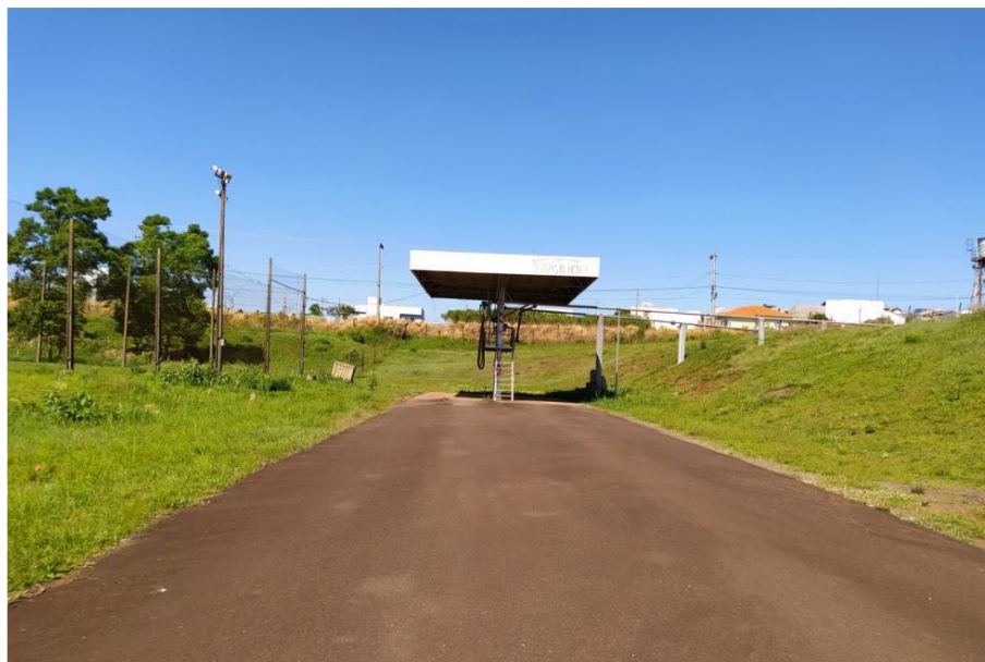
Base em Concreto
