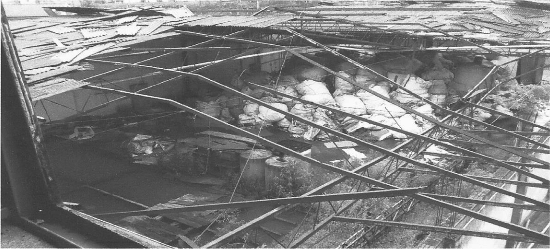
Local: Estação de tratamento de efluentes
