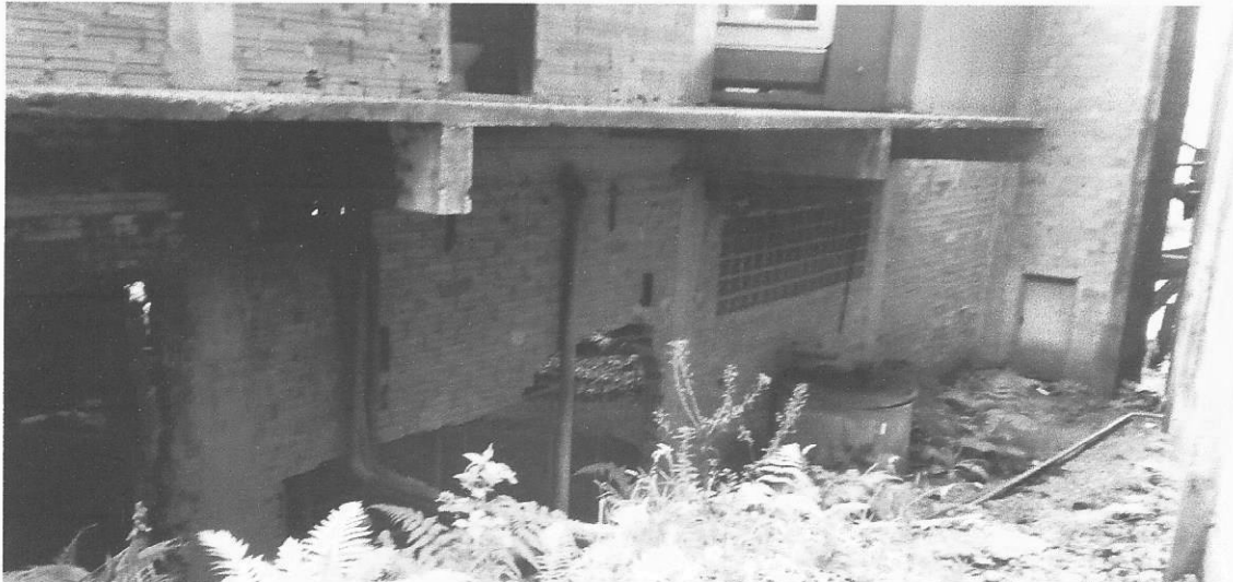
Local: Depósito de cavaco
