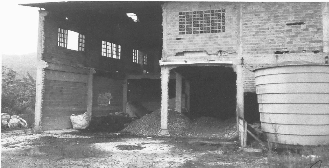
Local: Depósito de cavaco
