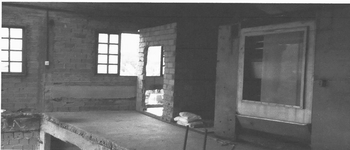
Local: Galpão antiga caldeira – Hoje depósito de cavacos
