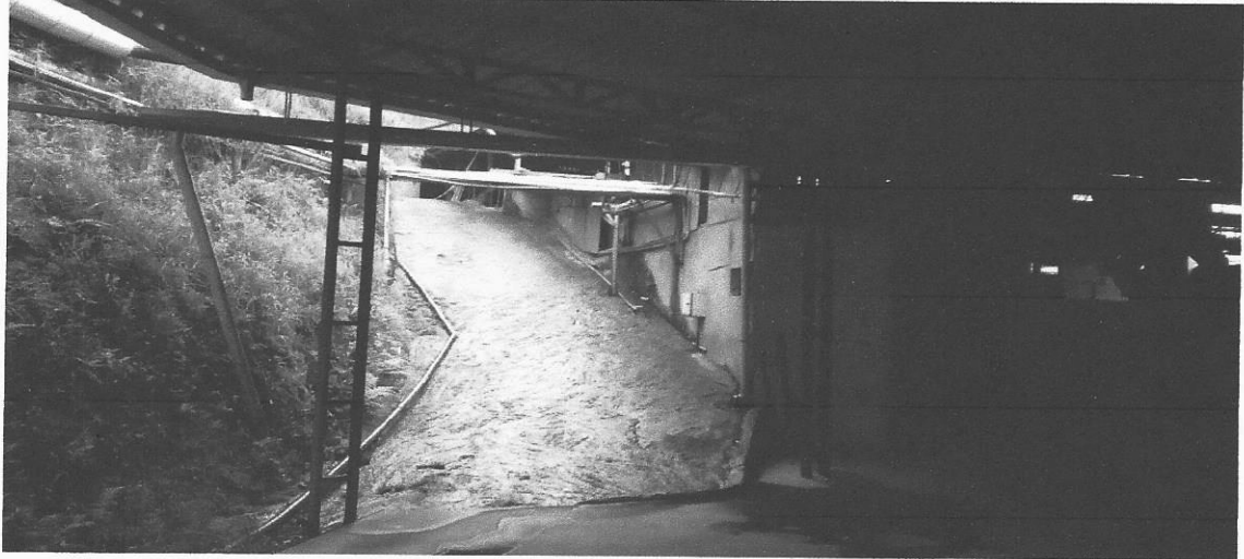
Local: Acesso galpão manutenção
