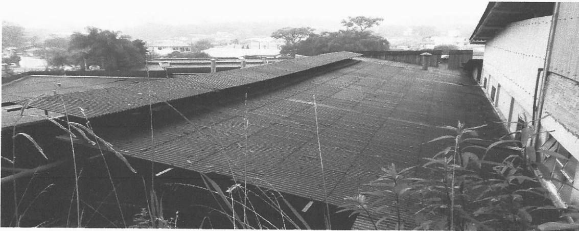
Local: Cobertura do galpão de produção
