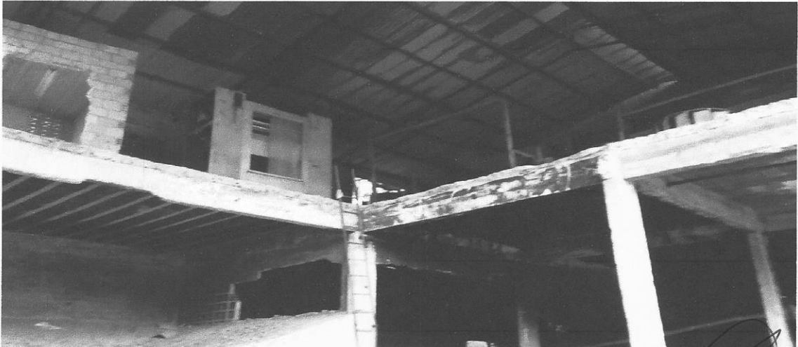
Local: Depósito de cavaco
