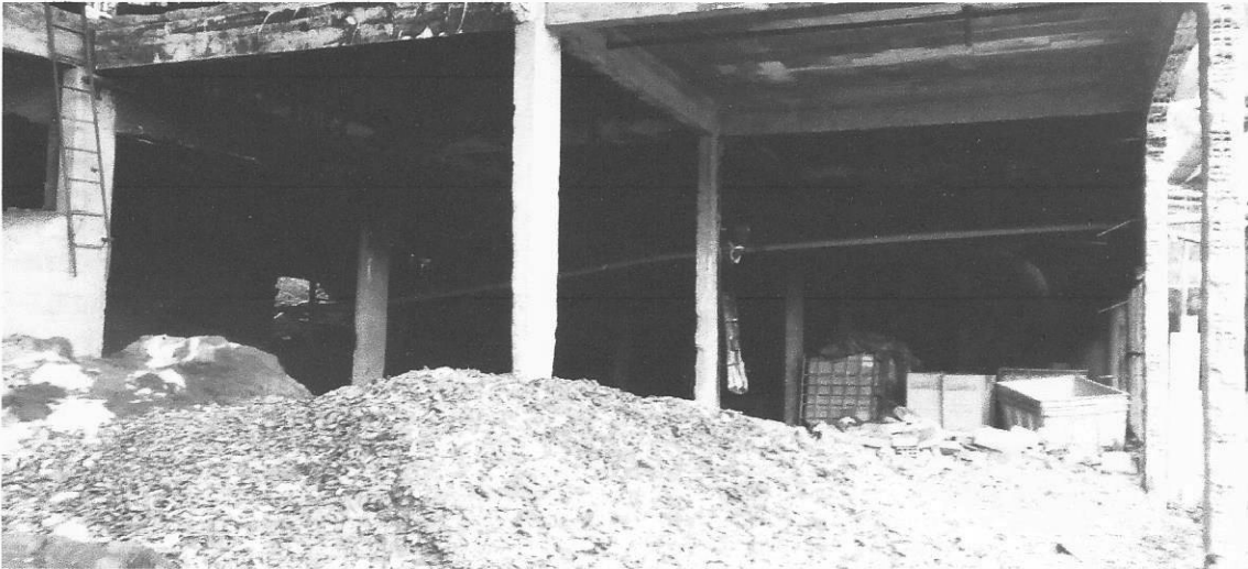
Local: Depósito de cavaco
