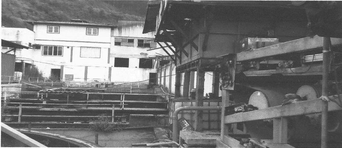
Local: Estação de tratamento
