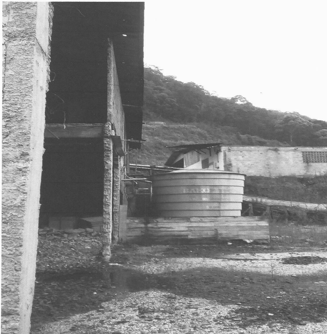
Local: Depósito de cavaco
