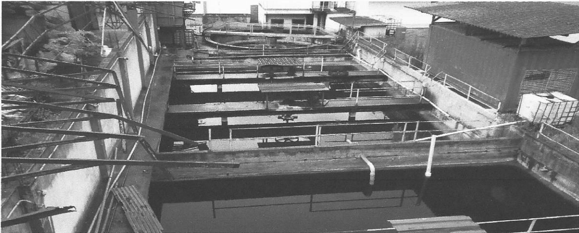
Local: Estação de tratamento de efluentes
