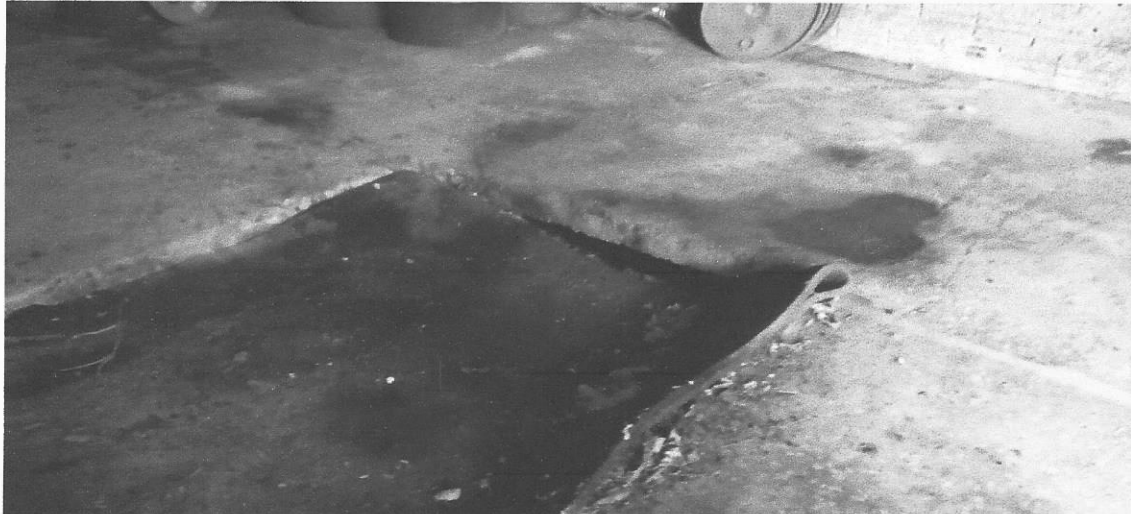
Local: Galpão antiga caldeira – Hoje depósito de cavacos
