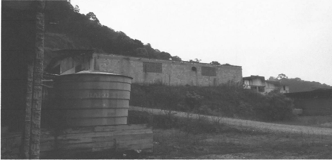
Local: Depósito de cavaco
