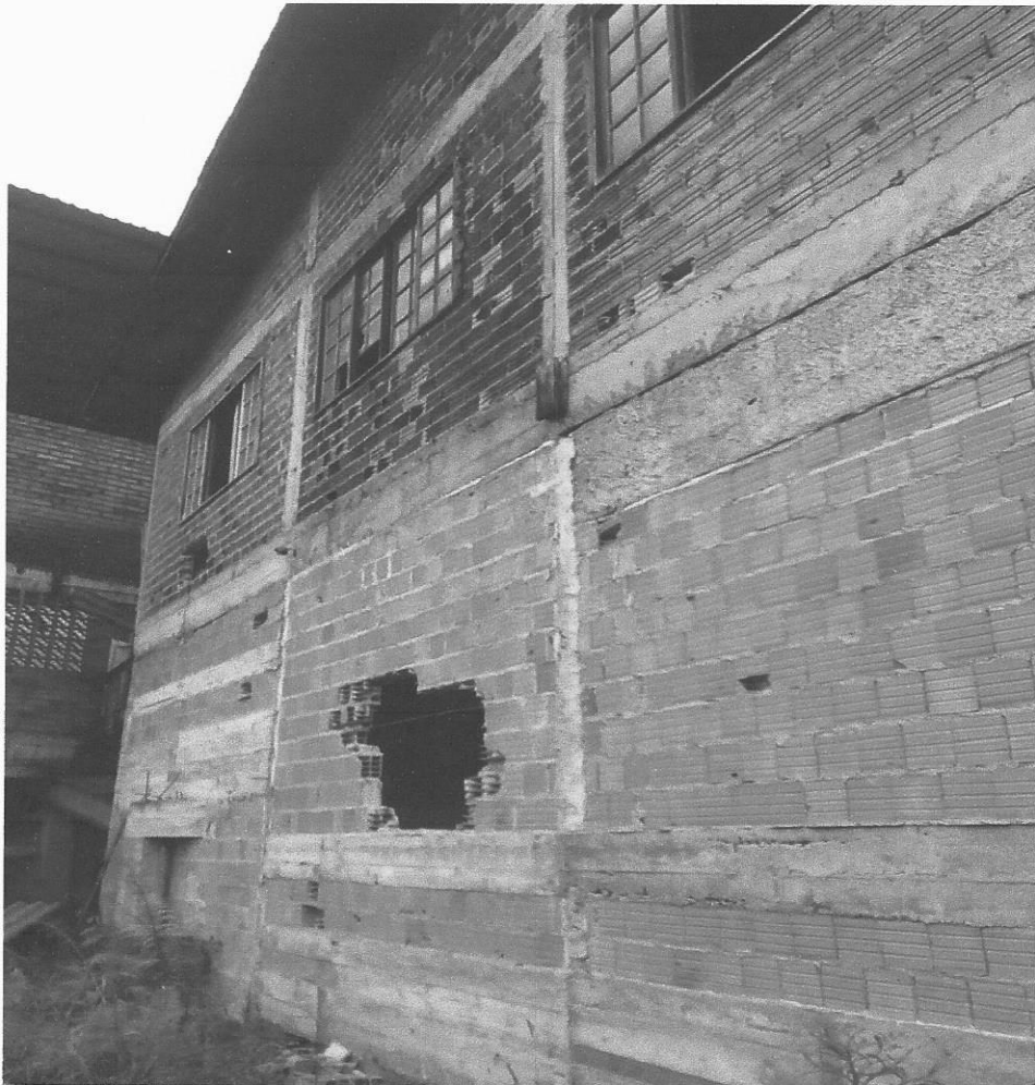
Local: Depósito de cavaco
