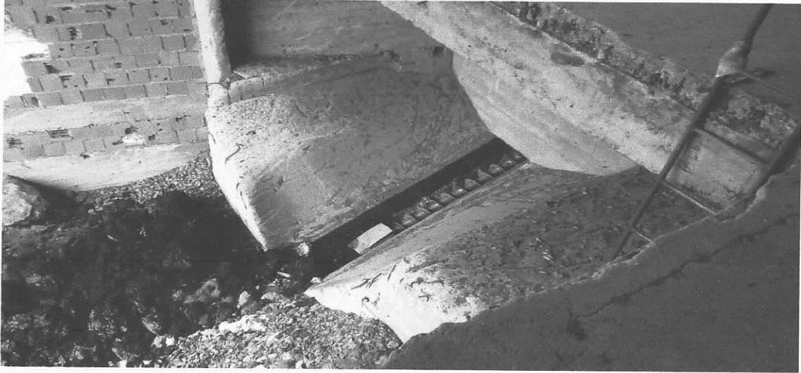
Local: Galpão antiga caldeira – Hoje depósito de cavacos
