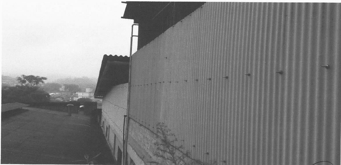
Local: Cobertura do galpão de produção
