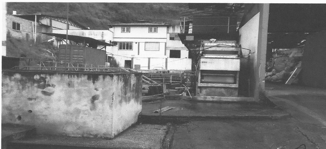
Local: estação de tratamento de efluentes
