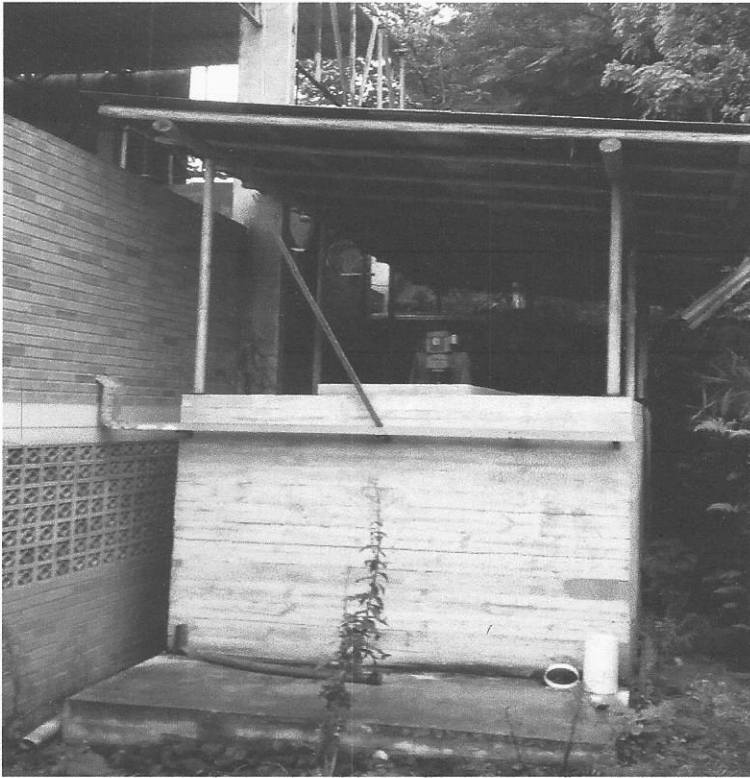
Local: Galpão caldeira
