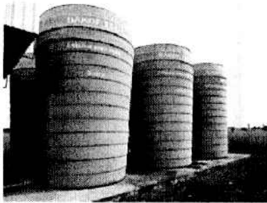
CAIXAS DE ÁGUA - CAPACIDADE 30.000 L (cada)
