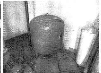
RESERVATÓRIO DE ÁGUA
