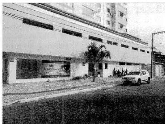
Vista da entrada à Portaria do edifício
