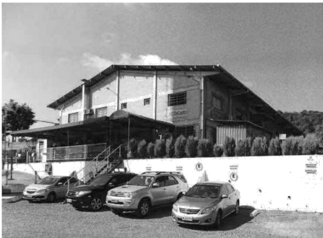
Figura 1: Fachada da Empresa
