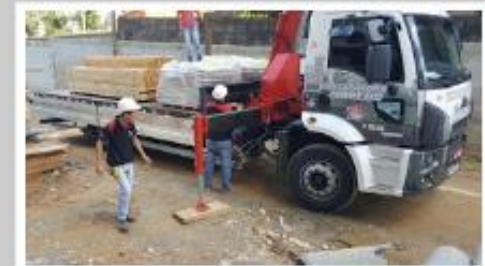
Chegada de argamassa e madeiramento da cortina
