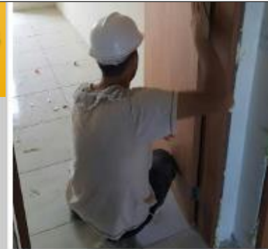
Lixação de portas após a primeira demão de verniz
