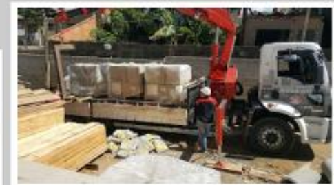
Chegada de piso cerâmico
