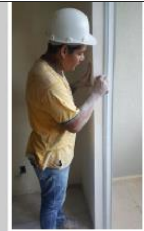
Lixação de acabamento de massa corrida no Floresta
